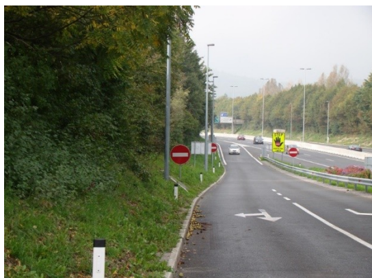
Slika 3. Ulaz u grad opremljen pasivno bezbjednim stubovima tipa 100HE3.
