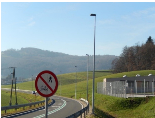
Slika 2. Pasivno bezbjedni stubovi u radnoj širini odbojne ograde.
