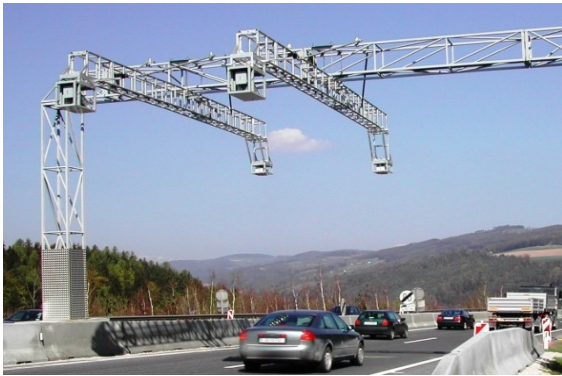
Slika 5. Izgled video kamera za detekciju prolaska na 2 presjeka dionice u Austriji ( http://www.efkon.com/en/news-media/Images/SectionSpeedControl.jpg , 16.03.2015.)
