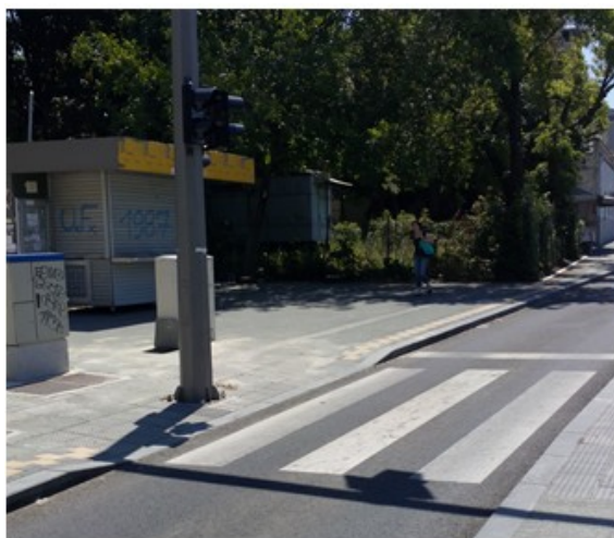
Slika 12. U fazi rekonstrukcije
