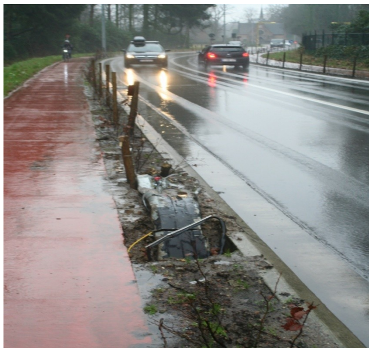
Slika 4. Pasivno bezbjedan stub pogođen sa suprotne strane vožnje funkcionisao je nezavisno o pravcu i mjestu udara. Gornji dio stuba već je maknut. (Safety Product, Carolien Willems)
