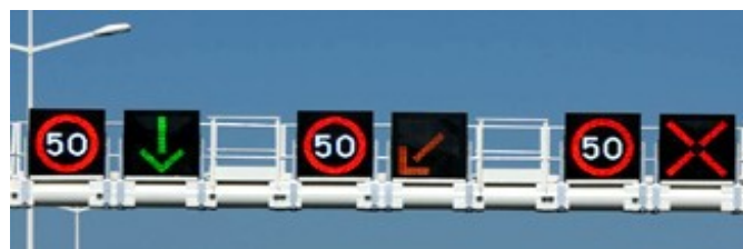
Slika 10. Znakovi za upravljanje brzinama po trakama ( http://www.roadtrafficttechnology.com/contractors/driver_info/microprocessor/microprocessor3.html , 17.03.2015.)
