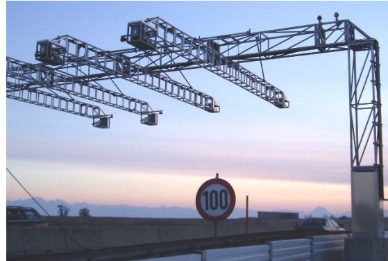
Slika 5. Izgled video kamera za detekciju prolaska na 2 presjeka dionice u Austriji ( http://www.efkon.com/en/news-media/Images/SectionSpeedControl.jpg , 16.03.2015.)
