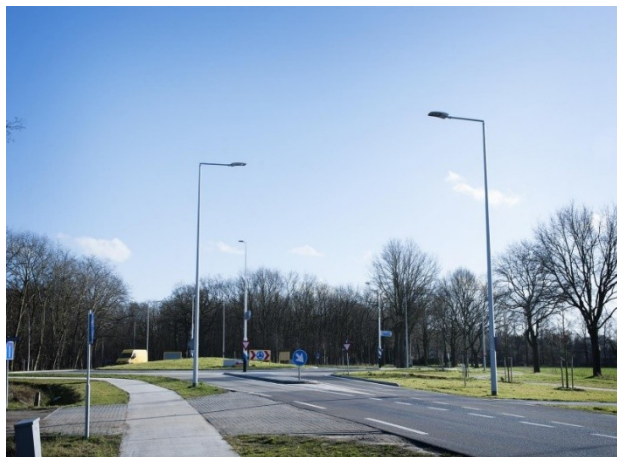
Slika 5. Kružna raskrsnica i prilazni putevi opremljeni pasivno bezbjednim stubovima javne rasvjete poštujući koncept oprastajućih puteva. (Safety Product, Carolien Willems)
