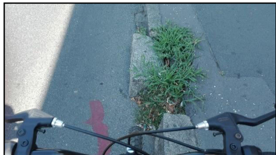
Слика 7. Приказ стања коловоза уз десну ивицу коловозне траке
