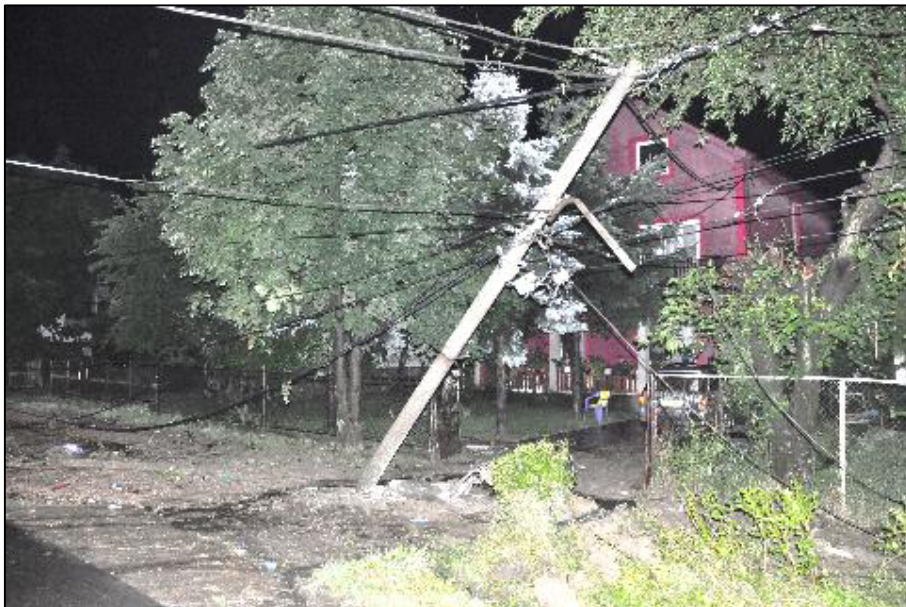
Слика 2. Пасивно небезбедан стуб
