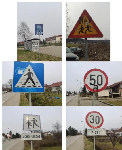
Слика 14. Оштећена вертикална саобраћајна сигнализација у зони школе
