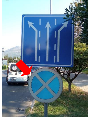
Slika 12. Izbledela površina saobraćajnog znaka
