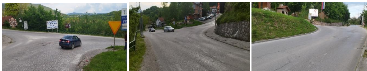
Slika 2. Izgled i položaj raskrsnice "Vraca"
