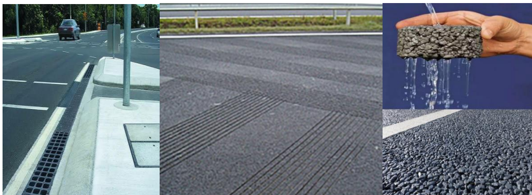
Слика 7. Изглед подужне каналице (лијево), “браздање” коловоза (средина) и порозног асфалта (десно) (Burlacu, Răcănel, and Burlacu 2018; Vettters n.d.; Wolff 2013)
